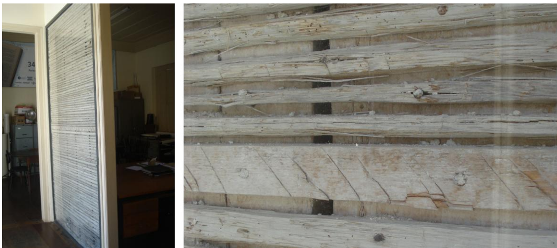
Figura 6: Nas duas imagens: Exemplo de parede interna realizada na técnica da estucaria, no sobrado residencial do barão de Butuí. Fonte: Fotos dos autores, 2010.
