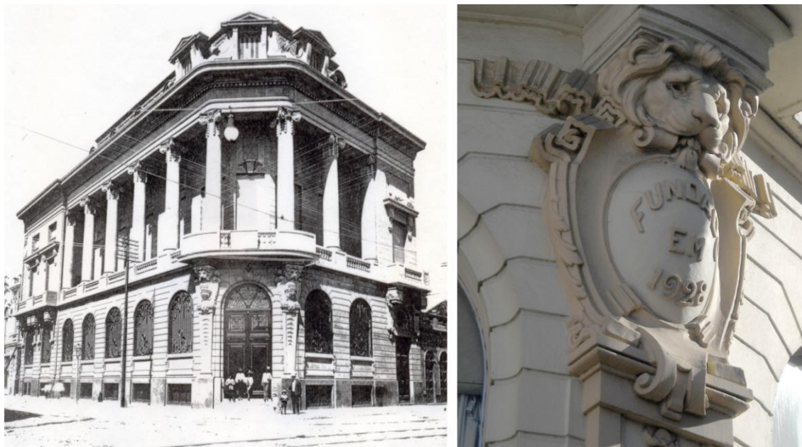
Figura 27: Na imagem à esquerda: Frontispício do antigo Banco Pelotense. Fonte: NOBRE, Nelson. Acervo do Projeto Pelotas Memória. Na imagem à direita: Brasão ornamentado com a cabeça de um leão, que ladeia a porta principal do edifício. Fonte: Foto dos autores, 2010.
