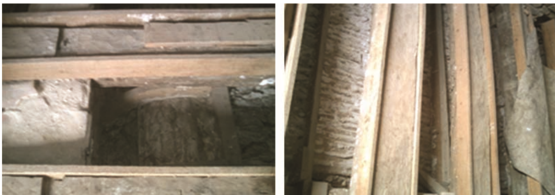
Figura 8: Nas duas imagens: Vigamento com fasquias de madeira para revestimento de estuque, no sobrado do barão de Butuí. Fonte: Fotos das autoras, 2008.
