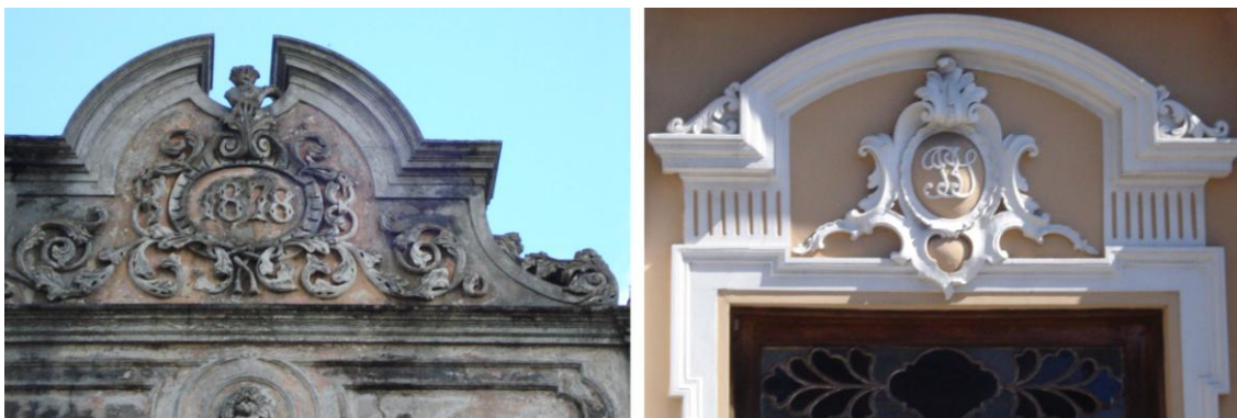
Figura 2: Na imagem à esquerda: Frontão que encima o frontispício do casarão do barão de Cacequi, com a data da construção do prédio, 1870. Na imagem à direita: Frontão que encima a porta de entrada do palacete da família de Bernardo de Souza, com o monograma do proprietário original. Fonte: Fotos dos autores, 2009.
