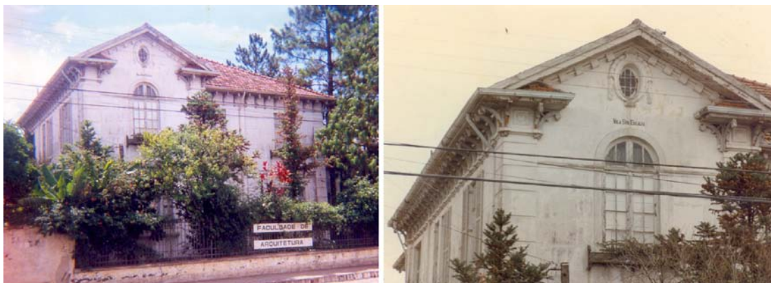
Figura 13: Nas duas imagens: A Vila Eulália, residência do administrador do Frigorífico Anglo. Fonte: Fotos do autor, 2007.
