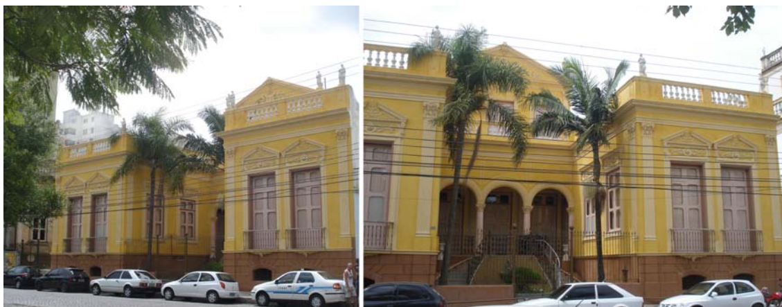
Figura 8: Nas duas imagens, a composição tripartida da fachada da residência do Barão de São Luis. Fonte: Fotos do autor, 2011.
