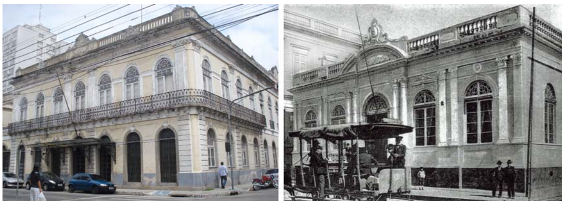
Figura 6: Na imagem à esquerda, 1: A residência do charqueador Felisberto Braga, atual Clube Comercial. Fonte: Foto do autor, 2011. Na imagem à direita, 2: O pavimento térreo de Biblioteca Pública Pelotense. Fonte: NOBRE, Nelson. Acervo do Projeto Pelotas Memória.
